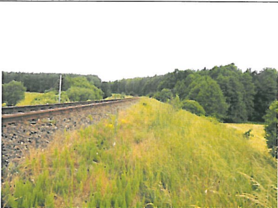
147. Linia Kolejowa nr 208 – Działdowo – Tuchola - Chojnice
