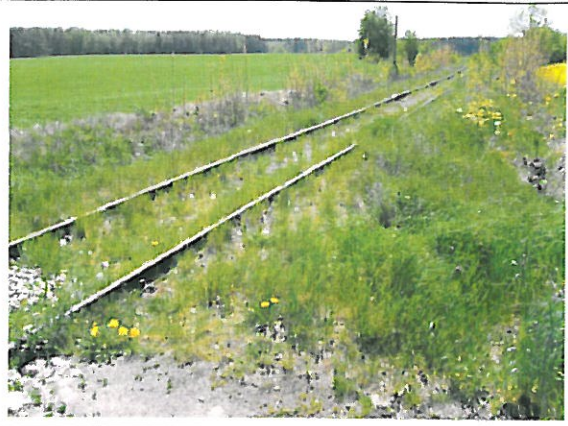
146. Linia kolejowa nr 241 – Koronowo - Tuchola
