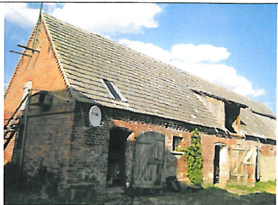
58. Pamiętowo, zagroda nr 22, budynek inwentarski
