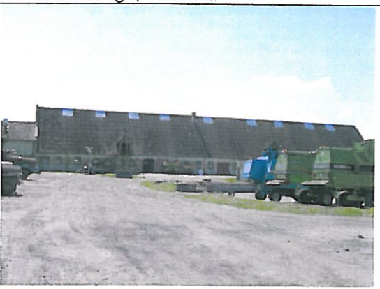
120. Wieszczyce, pozostałości zespołu dworskiego, stajnia, ob. bud. gospod.
