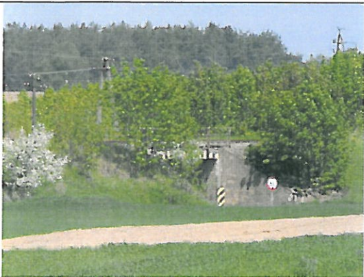
11. Brzuchowo, wiadukt kolejowy
