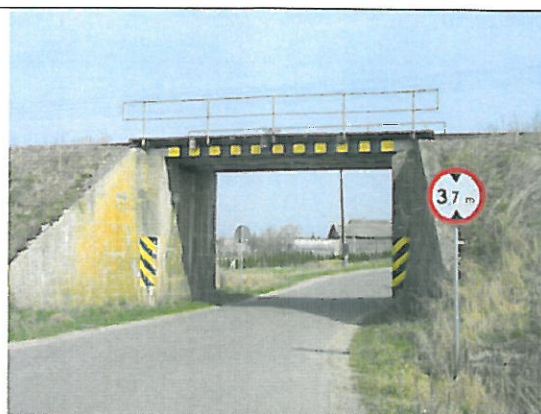
138. Żalno, wiadukt kolejowy – linia kolejowa nr 208
