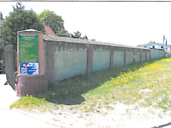
119. Wieszczyce, pozostałości zespołu dworskiego, ogrodzenie folwarku
